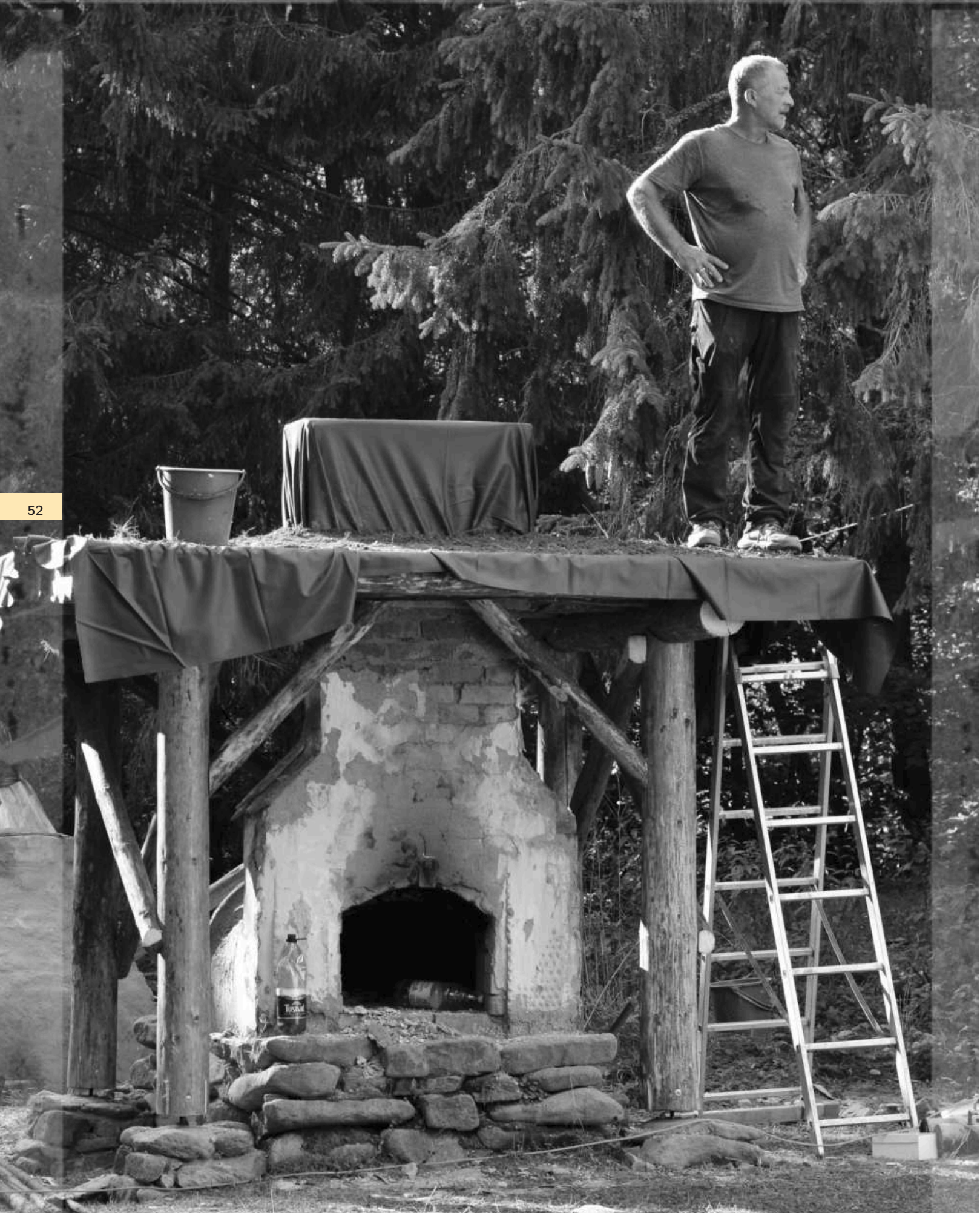
Az építészmuhely vezetője a „helyzet magaslatán”. Tető készül a sütőkemencéhez. / Şeful atelierului de arhitectură este „la înălţimea situaţiei”. Se construieşte un acoperiş pentru cuptor. / The head of the architecture workshop is “on top of the situation”. A roof is being prepared for the oven. Műhelyvezető / Coordonator atelier / Leader of the workshop: BENEDEK Elemér. Fotó / Foto / Photo: VÉSEY Vera (2022)
